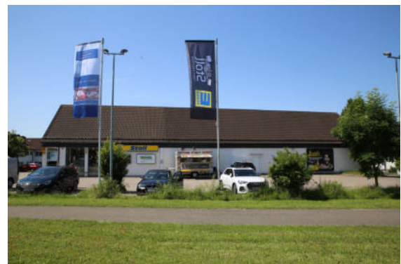
Abb. 30: Vollsortimenter in Bissingen
